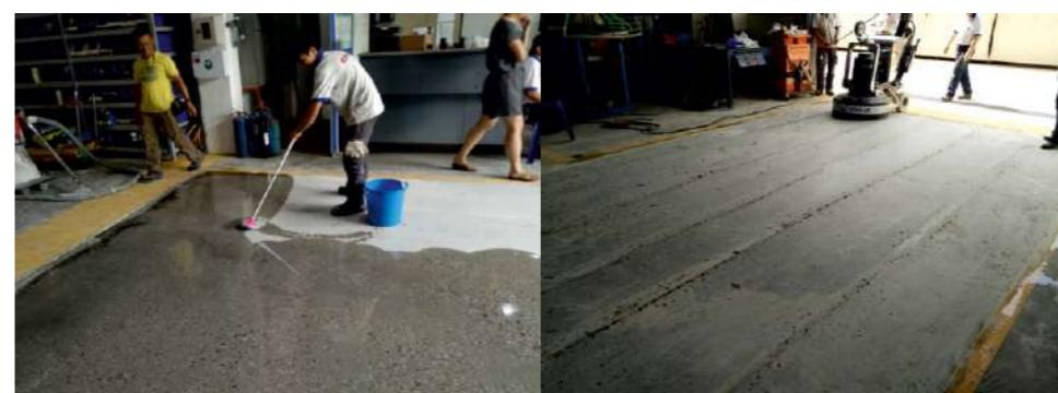
UYARI: Sertleştirme işlemi yapıldıktan sonra yüzeyi bir saat ıslak tutmak gereklidir. Bir sonraki parlatma işlemi için 24 saat beklemeliyiz.
