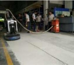
3. Yüzey temizlik makinesi 70A Global Wing & 65FL vakum makinesi ile yüzey temizlenir. Yüzeyin tamamen temizlenmiş olması ve yüzey üzerinde bulunan deliklerde hiç toz kalmaması gereklidir.
