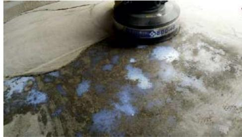
4. HTG-2Y 120# metal elmas ile yüzeyi silmeye devam ederiz ve silim tozu ve CPR Hole Filler ile kuş gözlerini tamir ederiz.
